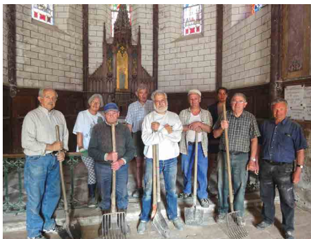
Déblaiement de la chapelle S te Anne
