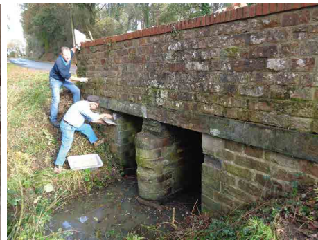
Restauration du pont du Tertre
